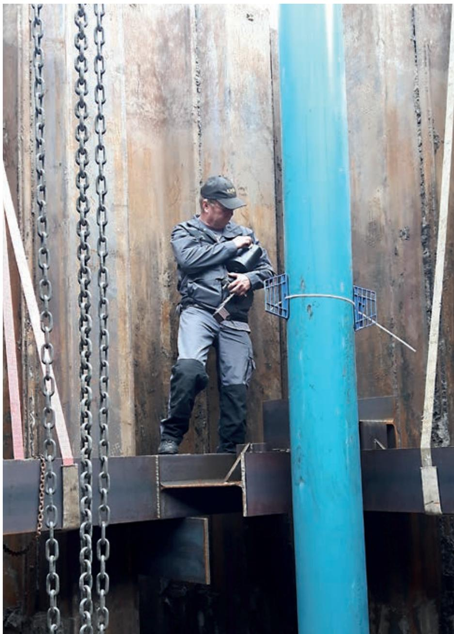
Um trockenen Fußes die Entschärfung in Oranienburg durchführen zu können, müssen erhebliche Wassermengen (bis 800m<sup>3</sup> und mehr) pro Stunde aus dem Boden gepumpt werden. Dies geschieht mit vielen sehr leistungsstarken Absaugrohren.
