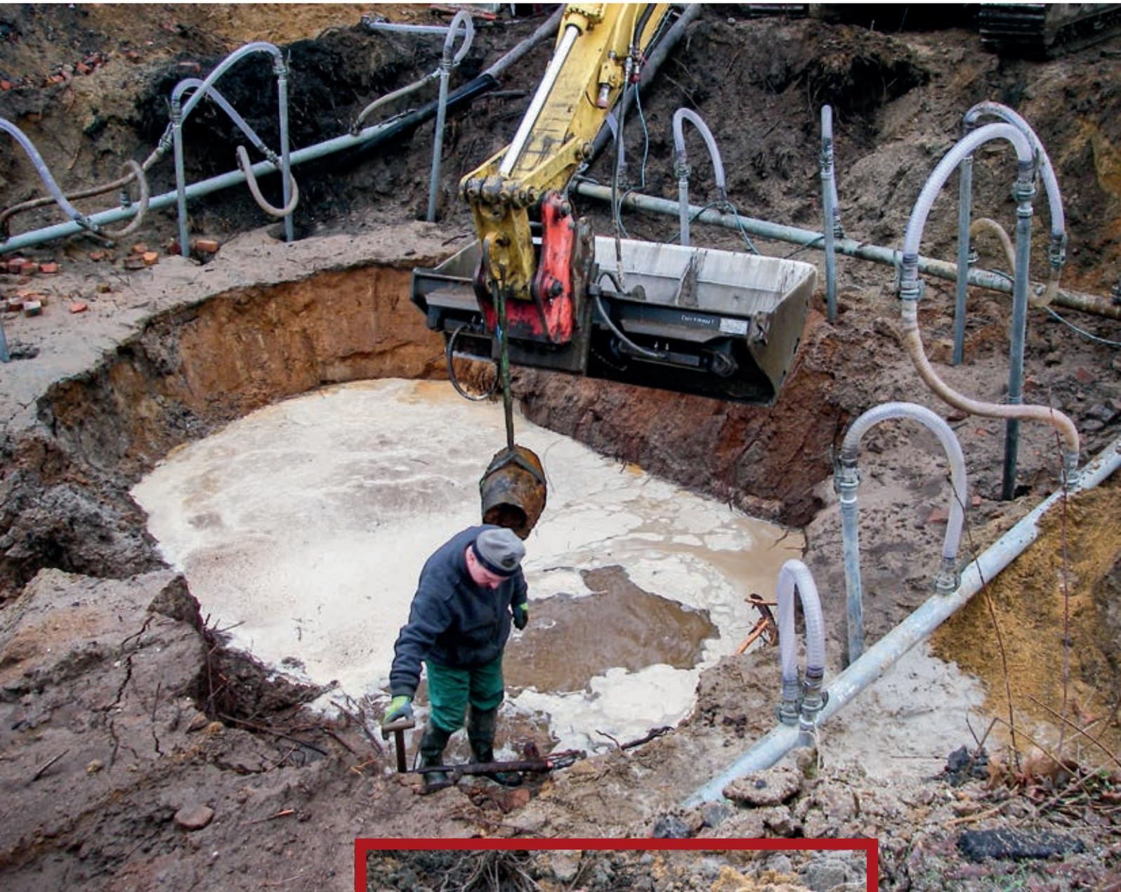
Der Grundwasser-Spiegel macht erhebliche Schwierigkeiten, es musste eine Grundwasserabsenkanlage errichtet werden.
